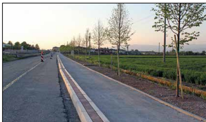
Lavori per completare la pista ciclabile.
